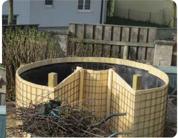
während der Bauphase
